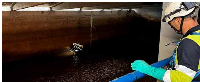
Los técnicos, durante los trabajos en el depósito.
