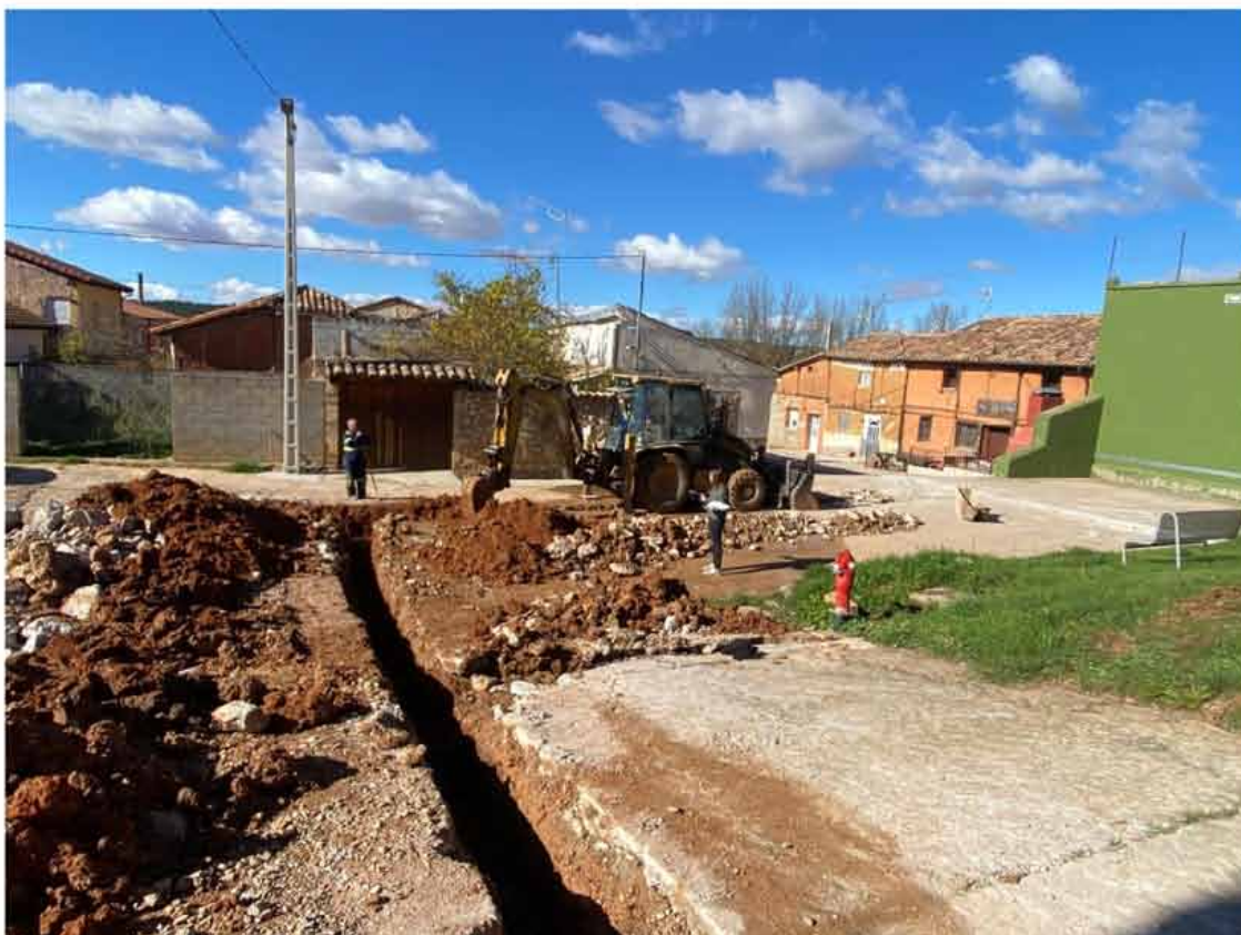
Obras en la Plaza de BarcebalejoAyto. Burgo de OsmaAyto. Burgo de Osma
