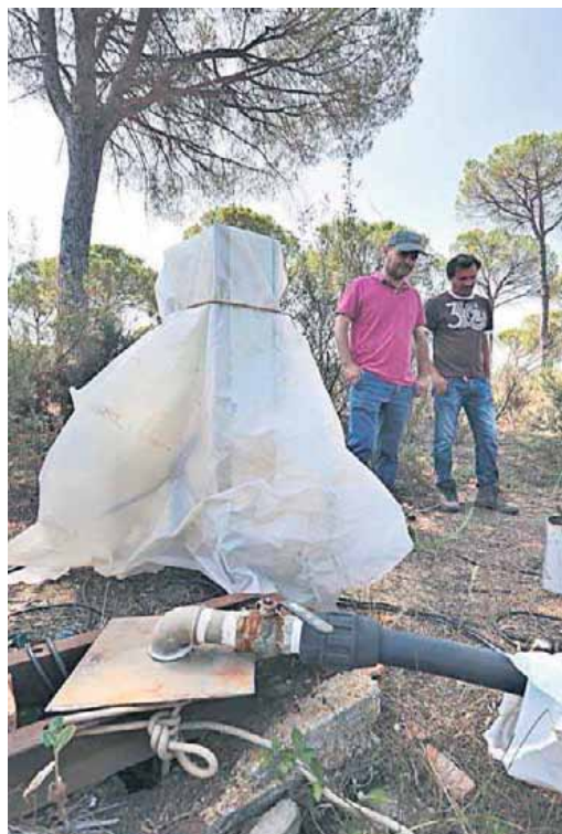
Un pozo irregular sellado en Lucena (Huelva), en el entorno de Doñana.
